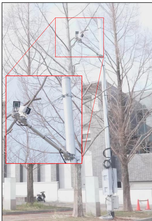
駐車場内に AI カメラを設置。駐車場内での一般車両検知や異常検知など、駐車場の安全確保に活用。
